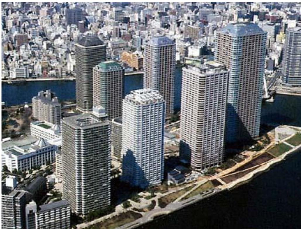
中央塔式结构，确保四面居室空间。MOS-DOC系统化施工，实现四天一层的施工循环。采用高强度流动混凝土。RIVER CITY 21计划是日本最初的超高层公寓。
