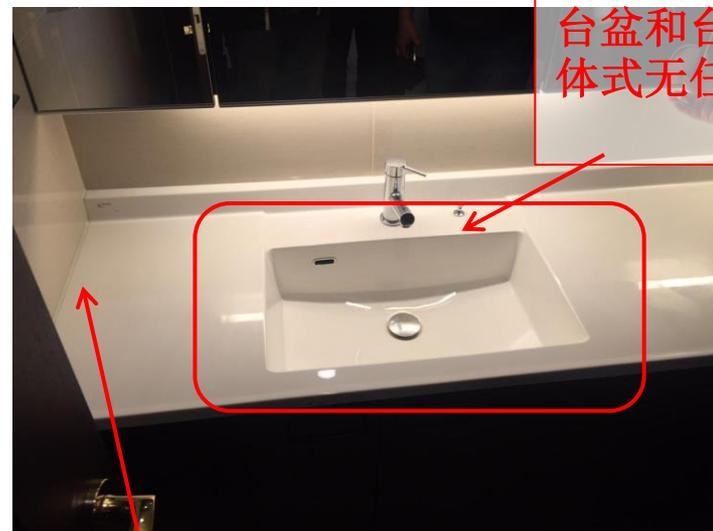
台盆和台面为一体式无任何缝隙
