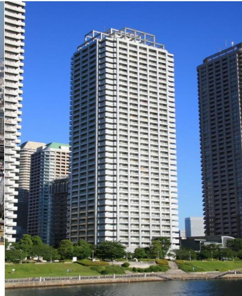
外周阳台上露出柱子·房梁的构造，最大限度地控制通往室内的柱子·房梁，确保宽敞的居住空间。同样采用DOC系统化施工，实现主体工程短工期内完成。采用超高强度(800kg/cm<sup>2</sup>)混凝土。
