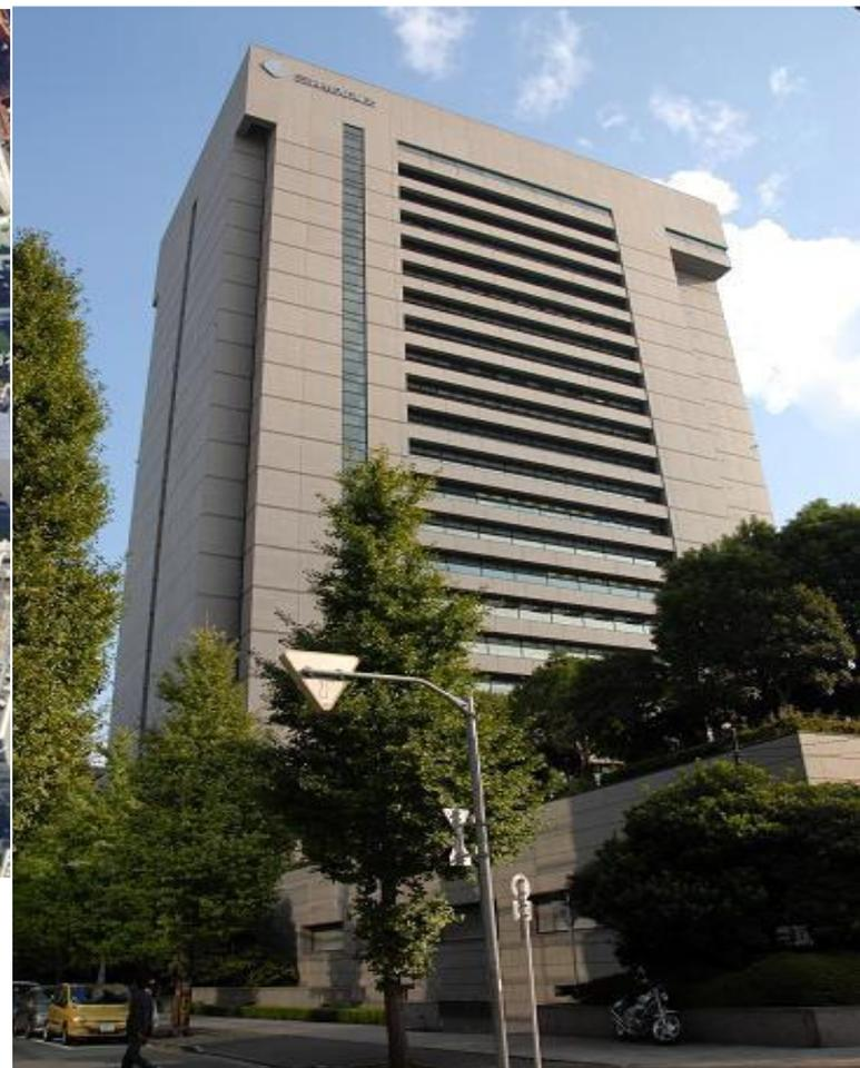
使用两侧核心构造方式实现了48m大跨度无柱设计，从而确保了办公区域空间。自动控制遮阳帘根据日照强度有效控制日晒，地下雨水存储槽实现了中水再利用，地下冷水存储槽实现了减小空调负荷的节能型建筑。
